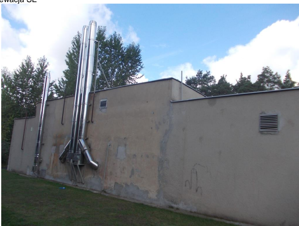
Fot.5. Elewacja SE
