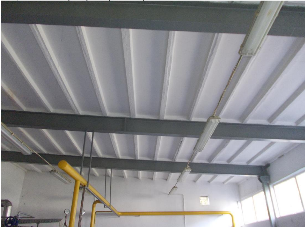
Fot.1. Strop kotłowni – część wyższa (środkowa)
