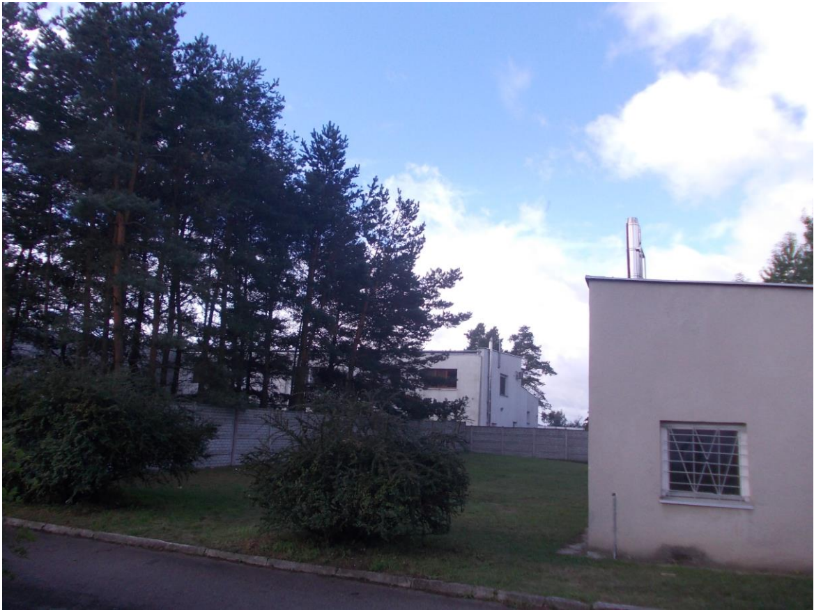
Fot.5. Elewacja NE
