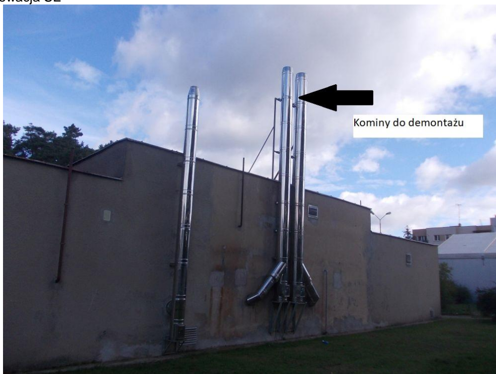
Fot.4. Elewacja SE
